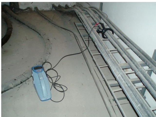
Obr.11 Správné napojení kleští na VN jednožilových kabelech
