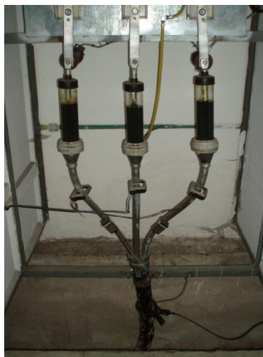
Obr.10 Správné napojení kleští na olejové VN kabely
